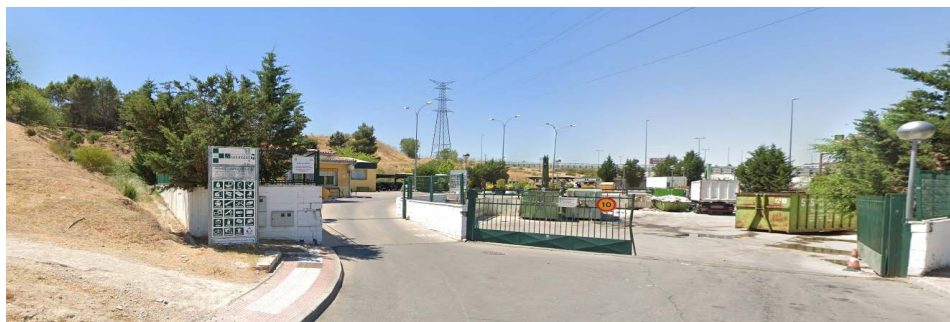
Figura 107. Punto Limpio de El Abajón
