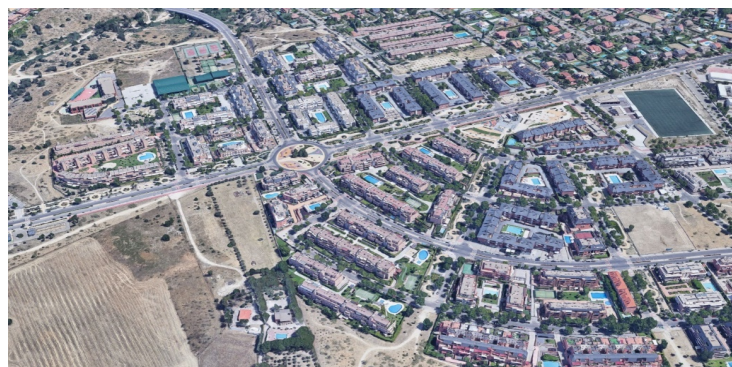
Figura 163. Imagen a vista de pájaro zona residencial colectiva oeste (fuente: google maps)
