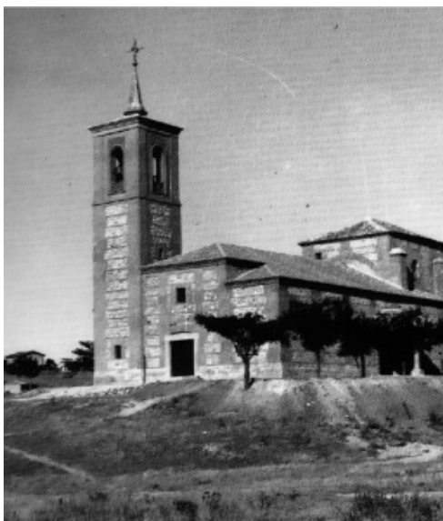
Figura 117. Iglesia reconstruida de San Miguel en 1943 (fuente: lasrozass.es)
